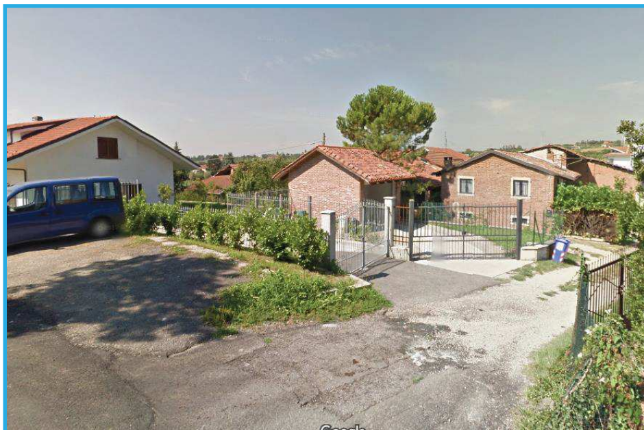
Terreni e Box auto – Subject (Foglio 12, p.lle 681, 682 e 886 - C.T.): vista da strada Sabena (da Google Maps - Street View)
